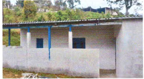
Foto 2: Cerco colocado y terminado
