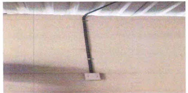
Foto 4: Reparación de sistema Eléctrico, terminado
