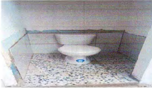
Foto 1: Servicios sanitarios puestos en su totalidad
