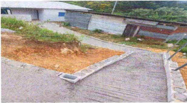
Foto 1: Losa de patio, fundida.
