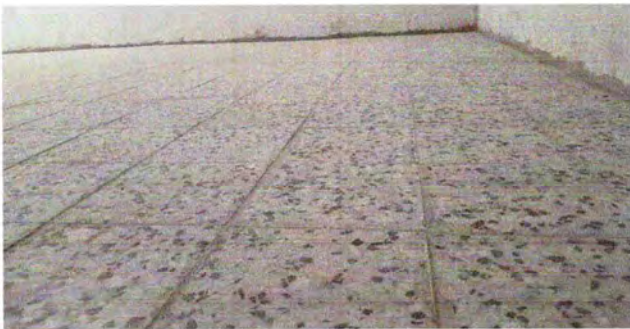
Foto 3: Piso puesto, finalizado
