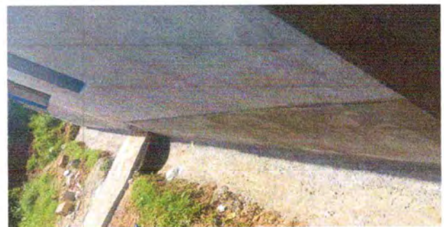
Foto 6: Impermeabilización de losa, fundida
