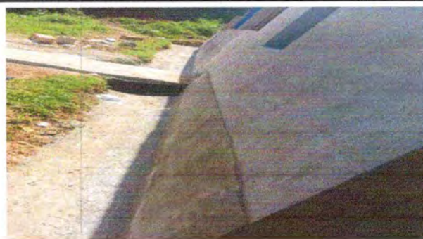
Foto 6: Impermivializacion de losa
