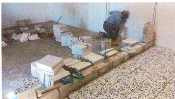
Foto 3: Puesta de piso
