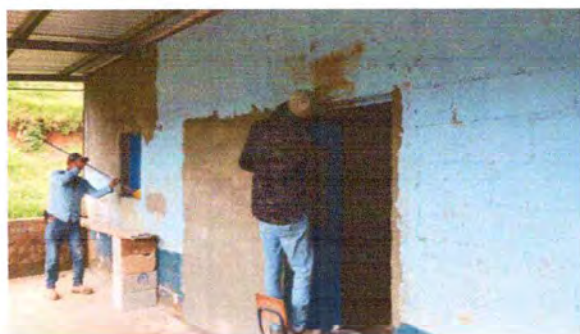
Foto 5: reparacion de cernido en paredes
