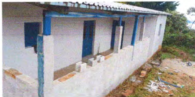
Foto 2: Reparacon de muro perimetral
