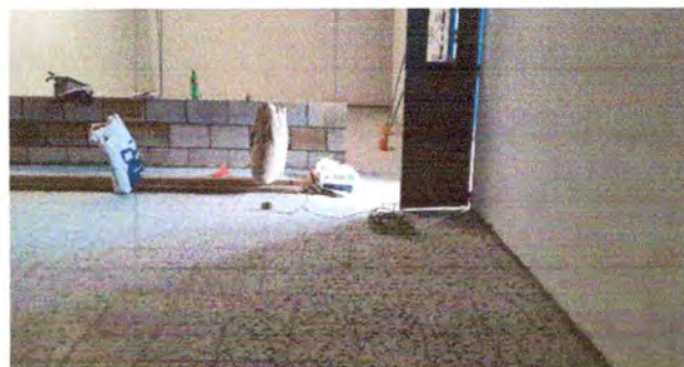
Foto 4: Reparacion de sistema electrico
