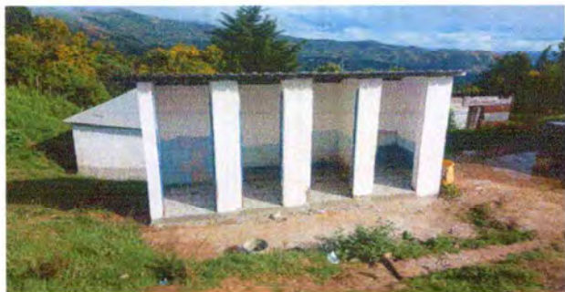
Foto 1: Reparacion de servicios sanitarios
