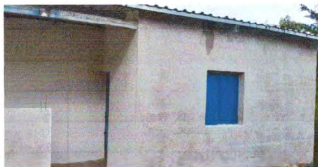
Foto 2: Reparación de puertas en mal estado
