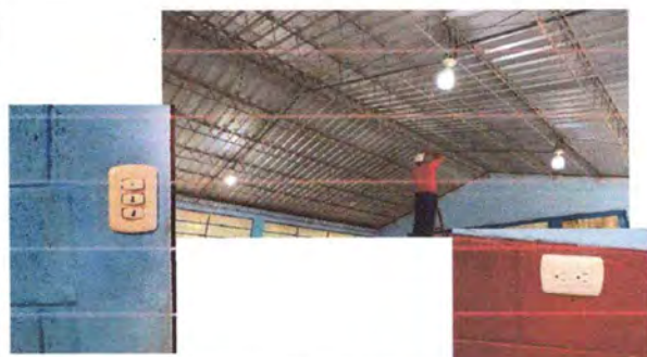
Foto 9: SUSTITUCION DEL SISTEMA ELECTRICO (LAMPARAS, TOMA CORRIENTES, APAGADORES)
