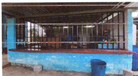
Foto 3: SUSTITUCION DE VENTANAS EN AREA DE COCINA
