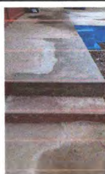
Foto 8: LOSA DE PATIO (SUSTITUCIÓN, ALISADO, INCLUYE BASE, DEMOLICIÓN Y EXTRACCIÓN)
