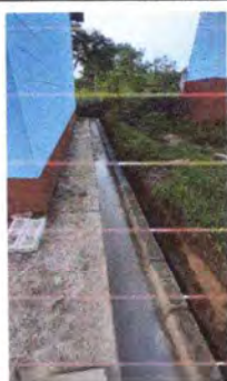
Foto 5: CUNETETA DE CONCRETO
