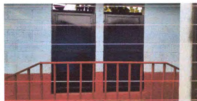
Foto 11: PUERTAS (REPARACION PUERTAS DE BAÑOS MODULO 2)
