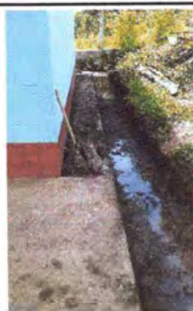
Foto 5: CUNETETA DE CONCRETO (Realizando limpieza y demolición de la anterior)
