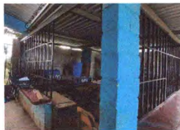
Foto 10: REPARACIÓN O SUSTITUCIÓN DE ÁREA DE COCINA (piso de concreto, pilas,puertas, otros)
