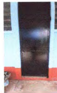
Foto 2: MANTENIMIENTO A PUERTAS DE AULAS (PINUTURA)
