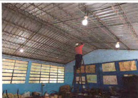
Foto 9: SUSTITUCIÓN DEL SISTEMA ELÉCTRICO (LÁMPARAS, TOMA CORRIENTES, APAGADORES)
