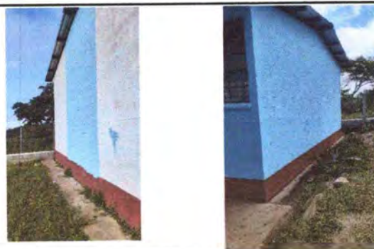
Foto 6: PINTURA EN MUROS INTERIOR Y EXTERIOR
