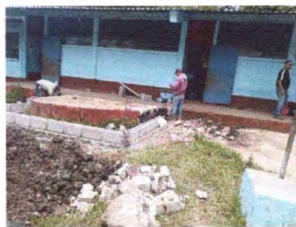
Foto 8: LOSA DE PATIO (SUSTITUCIÓN, ALISADO, INCLUYE BASE, DEMOLICIÓN Y EXTRACCIÓN)
