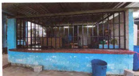
Foto 3: SUSTITUCIÓN DE VENTANAS EN ÁREA DE COCINA
