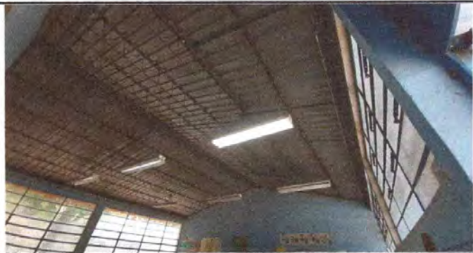
Foto 11: SE OBSERVA MALA ILUMINACIÓN EN AULAS YA QUE DE LAS 6 LÁMPARAS SOLO FUNCIONAN 2
