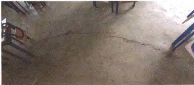
Foto 5: SUSTITUCIÓN PISO DE CONCRETO
