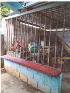
Foto 4: SUSTITUCIÓN DE VENTANAS EN ÁREA DE COCINA DEBIDO AL ALTO DETERIORO Y OXIDACIÓN DEL MISMO.
