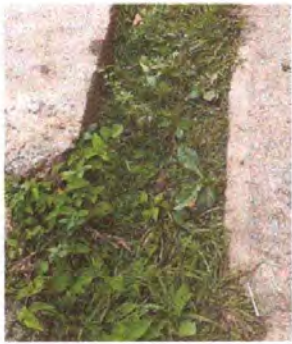
Foto 7: REPARACIÓN CUNETAS DE CONCRETO
