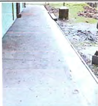
Foto7: cambio de losa de patio (incluye base)
