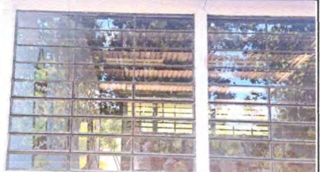
FOTO 4: Se instaló ventana en aula
