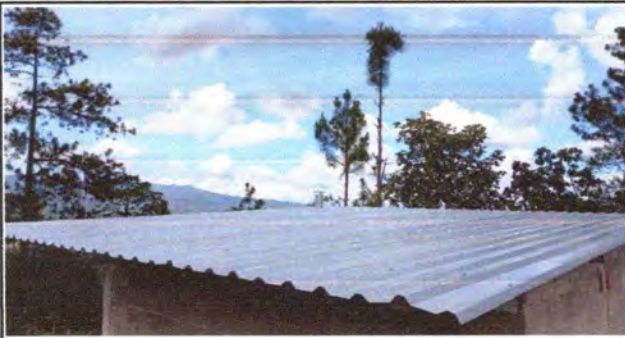
Foto1: CUBIERTA DE LAMINA DE FIBROCEMENTO A LAMINA TROQUELADA CALIBRE 26
