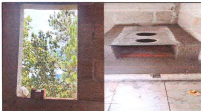
Foto 9: sustitución de área de cocina
