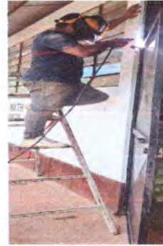
FOTO 2: Instalación de puerta en aula
