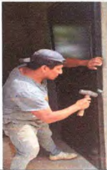
Foto3: instalación de puerta en baños
