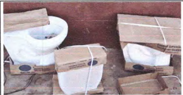
Foto: 6 sustitución de sanitarios y sus accesorios
