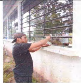
Foto4: sistitución de ventanales
