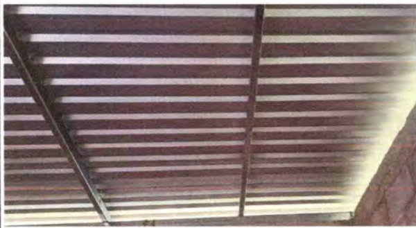
Foto1: sustitución de techo
