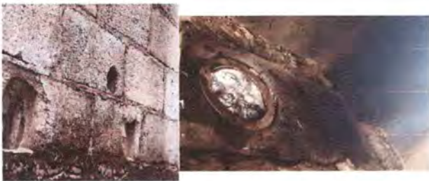
Foto 9: Se observa que el interiør de la cocina necesita sustitución
