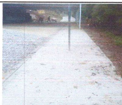
Foto 4: SUSTITUCIÓN LOSA DE PATIO
