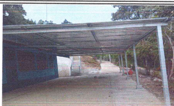
Foto 2: SUSTITUCIÓN DE LAMINA TROQUELADA CALIBRE 26
