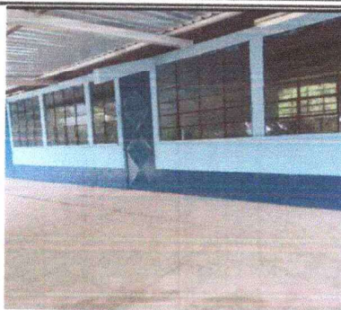
Foto1: PINTURA EN MURO INTERIOR Y EXTERIOR
