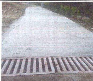
Foto 3: SUSTITUCIÓN LOSA DE PATIO
