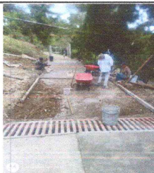
Foto 4: SUSTITUCIÓN LOSA DE PATIO
