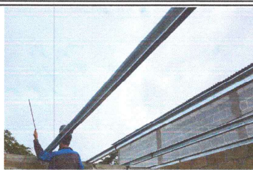
Foto 2: SUSTITUCIÓN DE LAMINA TROQUELADA CALIBRE 26
