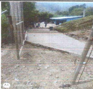
Foto 3: SUSTITUCIÓN LOSA DE PATIO
