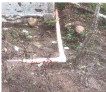
Foto 3: SE OBSERVA EL TRABAJO PARA LA NUEVA TUBERIA PARA EL AGUA PLUVIAL QUE VALLA HACIA FUERA
