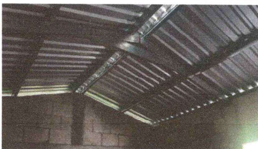
Foto 1: SE VE LA NUEVA ESTRUCTURA PARA EL TECHO DE COCINA
