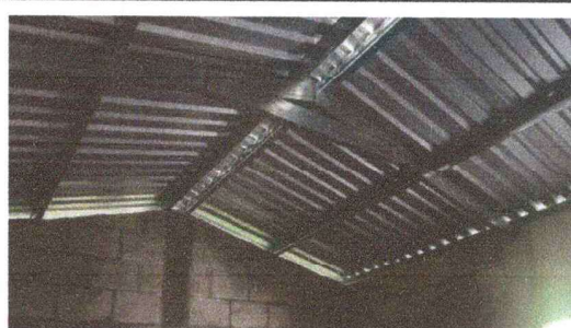
Foto 2: SE LE ESTA PONIENDO NUEVA ESTRUCTURA PARA LA COCINA
