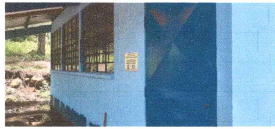
Foto 2: SE OBSERVA EL AVANCE EN EL TRABAJO DE LA NUEVA PINTURA EN EL EXTERIOR
