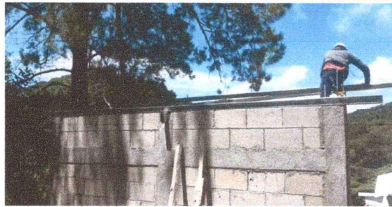
Foto 1: SE VE LA NUEVA ESTRUCTURA PARA EL TECHO DE COCINA
