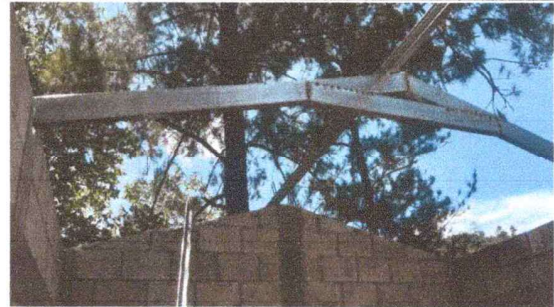
Foto 2: SE LE ESTÁ PONIENDO NUEVA ESTRUCTURA PARA LA COCINA
