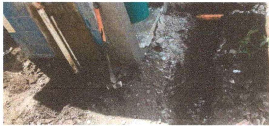
Foto 3: SE OBSERVA EL TRABAJO PARA LA NUEVA TUBERÍA PARA EL AGUA PLUVIAL
