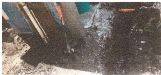
Foto 6: SE ESTÁ HACIENDO EL CAMBIO DE LA NUEVA TUBERÍA PARA LOS DRENAJES DE LOS BAÑOS
