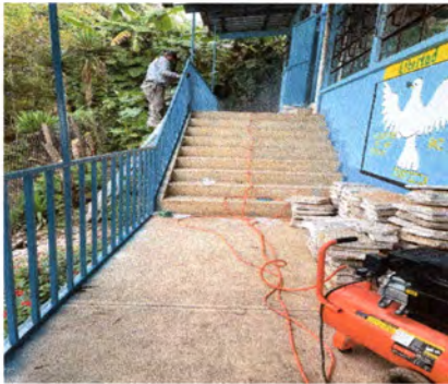
Foto1: Suministro e Instalación de reja de metal 32.50 x 1.50
