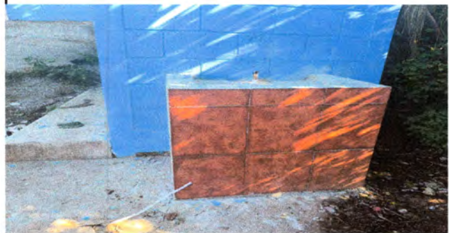
Foto 4: Desmontaje, suministro de labamano y su accesorio.
