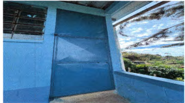
Foto 2: Mantenimiento a puerta de metal lijado, cepillado, sujeciones, aplicación de 2 manos de pintura anticorrosiva) 3.30*1.00
