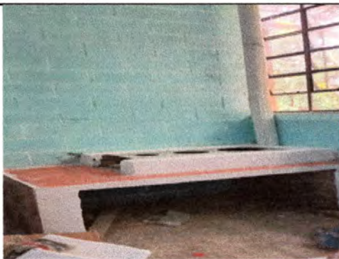
Foto 5: Mejoramiento de plancha de concreto reforzado con azulejo.
