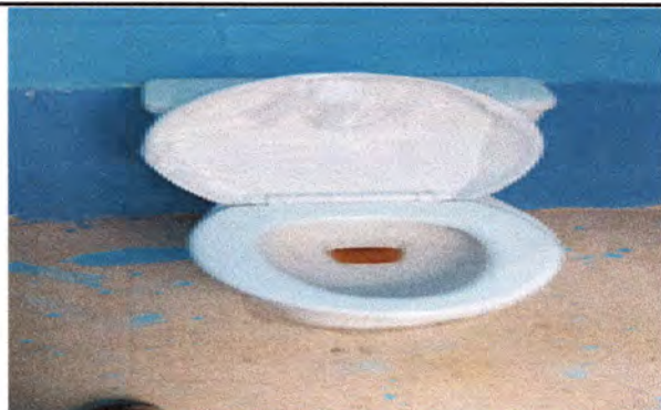
Foto 4: Desmontaje, suministro e instalación de accesorios inodoro (contra llave, tubo de abasto y kit de tanque)
