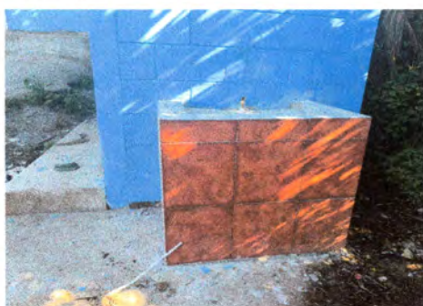
Foto 5: Mejoramiento de lavamanos con plancha de concreto reforzado con azulejo (incluye accesorios)
