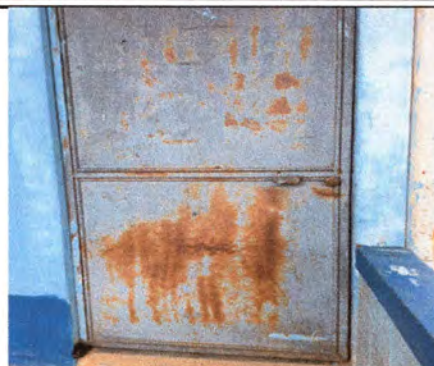
Foto 2: Mantenimiento a puerta de metal lijado, cepillado, sujeciones, aplicación de 2 manos de pintura anticorrosiva) 3.30*1.00
