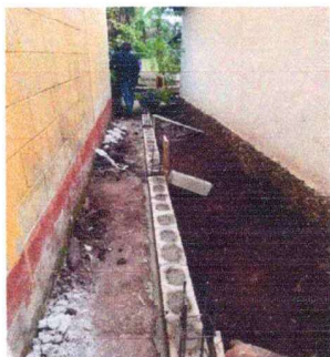
Foto 3: sustitución de muro perimetral en proceso (muro de malla)
