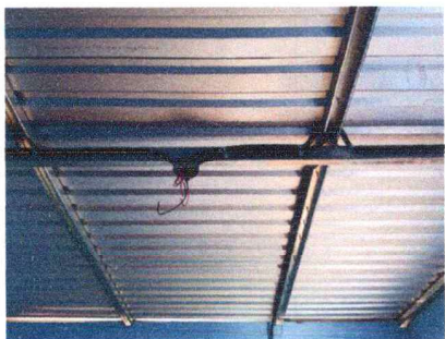
Foto 5: sustitución de sistema electrico en proceso
