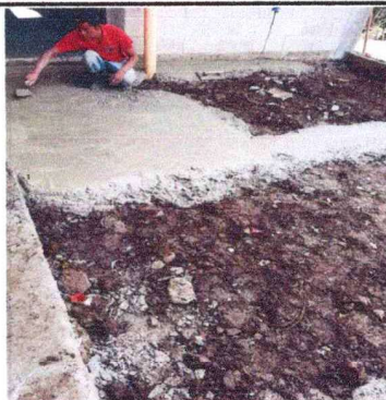
Foto 2: Sustitución de Losa de patio en proceso
