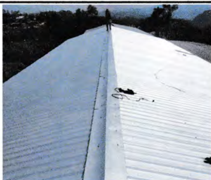
Foto 5: Inspeccionando el techado.
