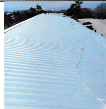
Foto 6: Finalizando el techado
