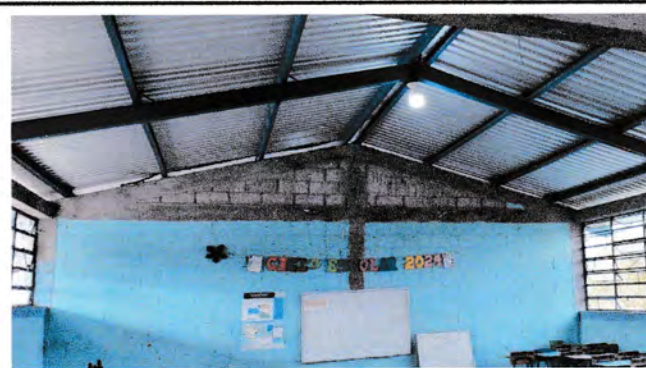
Foto 4: Foco y Plafonera nueva salón 2
