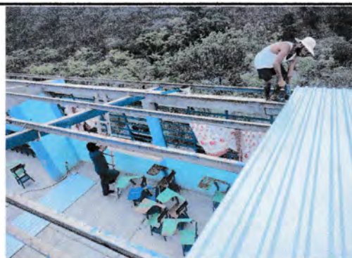
Foto 6: Seguimiento del techado de lámina
