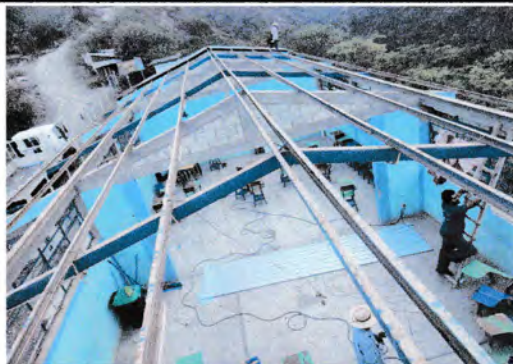
Foto1: Inicio de montaje de lámina
