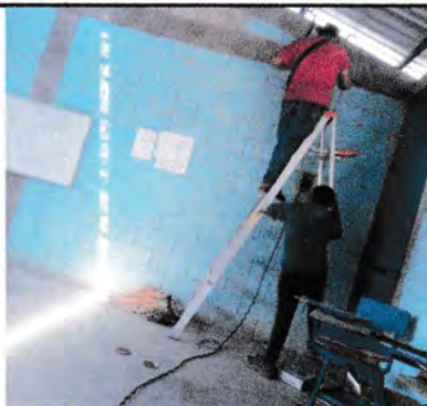
Foto 5: Reparación del Sistema Eléctrico
