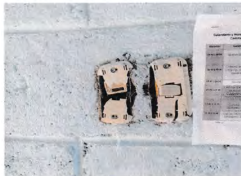
Foto 4: Apagadores deteriorados.
