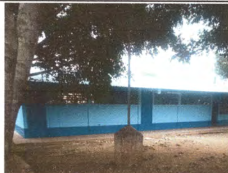
Foto 2: Estructura metalica reparada.
