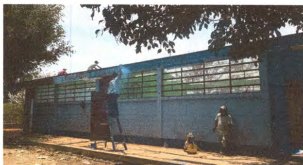
Foto 2: Recinstrucción de estructura metálica.
