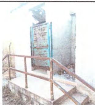
Foto 5: Mantenimiento de puertas.
