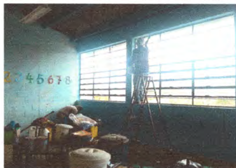
Foto 6: Pintura de interior.
