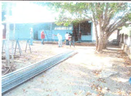
Foto 3: Reconstrucción de techo.
