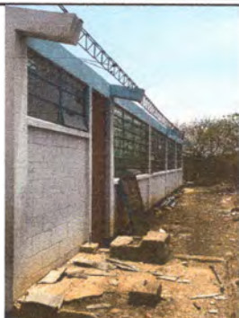
Foto1: Reconstrucción de canales.
