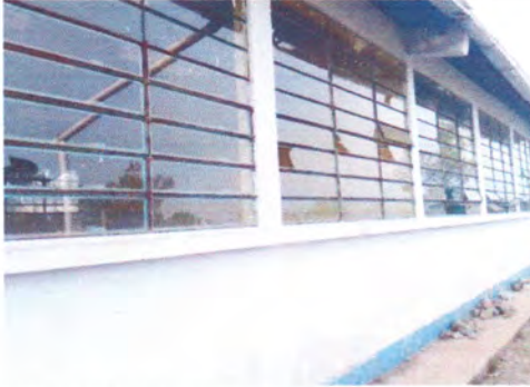
Foto1: reparación de ventanas y pintura en muros interior y exterior
