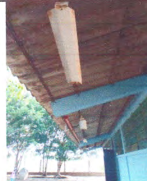
Foto4: Reparacion del sistema electrico
