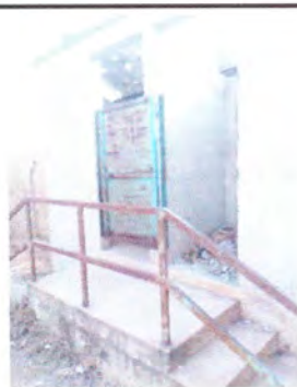
Foto: 5 Mantenimiento de puertas
