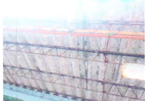
FOTO 2: Cambio de laminas, reparacion de estructura de techo
