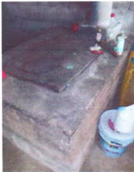
Foto3: Reparacion de area de cocina
