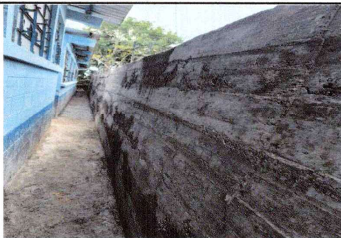
Foto1: Sustrucción de muro de contención ciclopeo.
