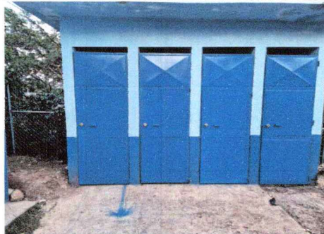
Foto 3: Reparación en puertas existentes en módulo de baños, pintura y cambio de chapas.
