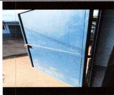
Foto 2: Reparación de puerta existen, pintura y cambio de chapa
