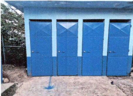
Foto 3: Reparación en puertas existentes en módulo de baños, pintura y cambio de chapas.
