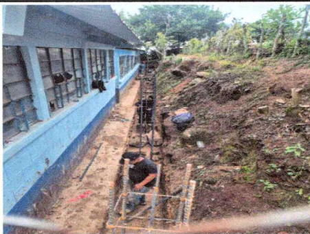
Foto 1: Sustitución de muro de contención ciclopeo, incluye preparación de terreno, materiales y tallado.
