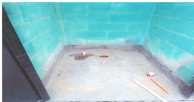
Foto 5: PREPARANDO LA INSLACIÓN PARA EL NUEVO SANITARIO
