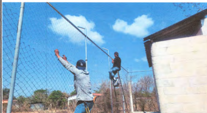
Foto 2: REPARACION DE MALLA
