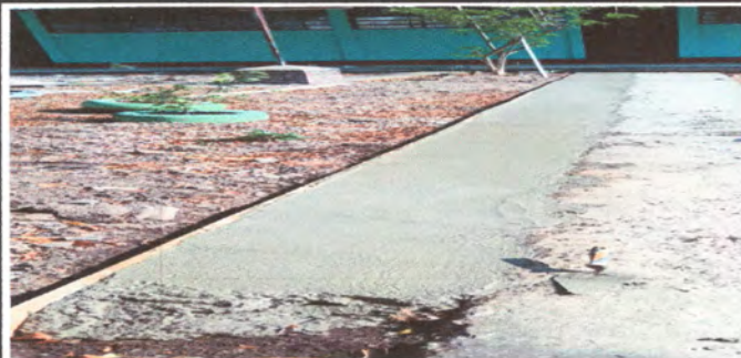
Foto 6: REPARACION DE LOSA DAÑADA
