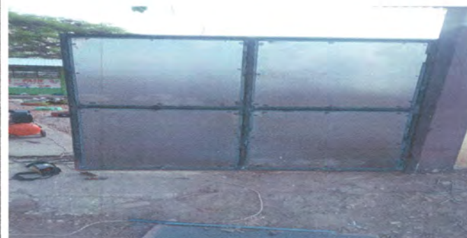
Foto 4: REPARACIÓN DEL PORTON ENTRADA
