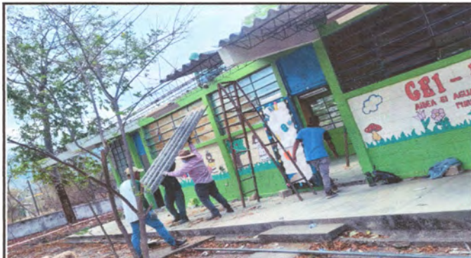
Foto 3: COLOCADO DE LAMINA NUEVA
