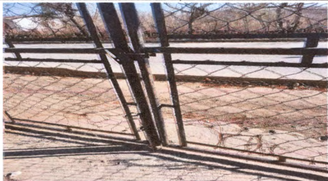
Foto 1: PORTON ENTRADA PRINCIPAL
