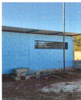
Foto1: CUBIERTA DE LAMINA
