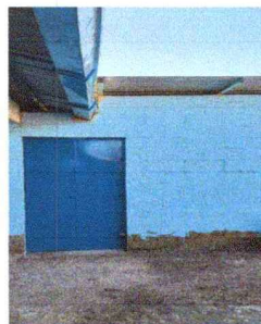
Foto 2: ESTRUCTURA DE TECHO
