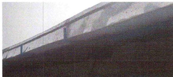
Foto 4: CANALES Y BAJADAS DE AGUA PLUVIAL
