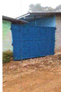
Foto 6: MANTENIMIENTO A PORTONOS
