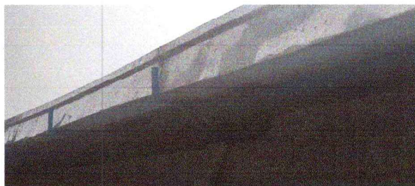
Foto 4: CANALES Y BAJADAS DE AGUA PLUVIAL
