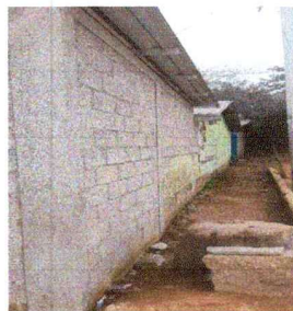
Foto 2: ESTRUCTURA DE TECHO
