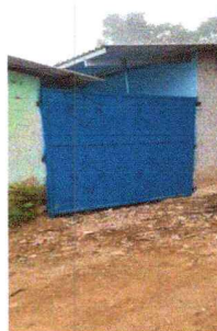
Foto 6: MANTENIMIENTO A PORTONOS
