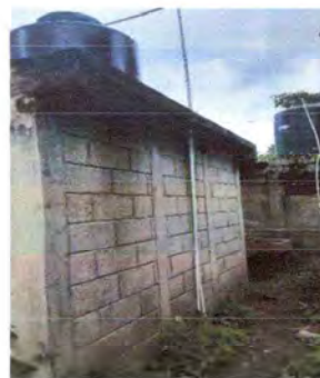
Foto 8: Finalización de red de agua potable
