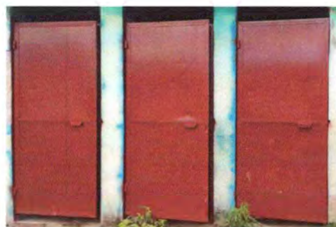
Foto 4: Puertas de sanitarios reparadas.
