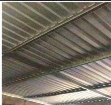
Foto 1: Cubierta de lámina instalada
