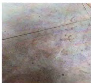
Foto 5: Construido piso liso.
