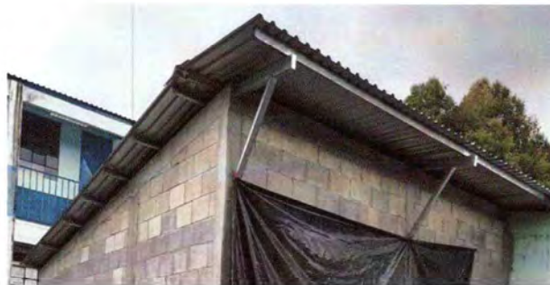
Foto 2: Instalacion de Estructura de techo
