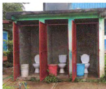
Foto 6: Instalacion de servicios sanitarios
