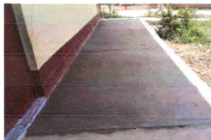
Foto 10: Construida losa de patio.
