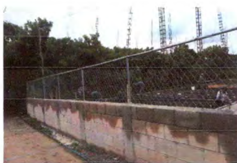
Foto 9: Muro Perimetral construido.
