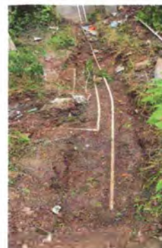
Foto 8: Instalacion de red de agua Potable
