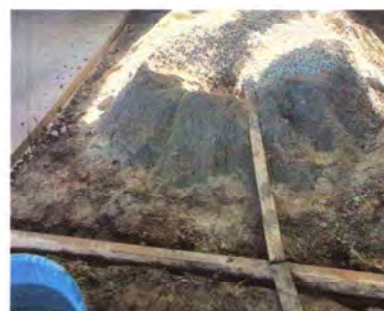
Foto 10: Construcción de losa de patio
