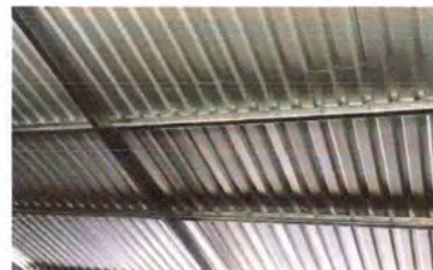
Foto 2: Instalación de estructura metálica
