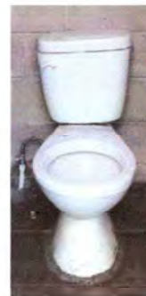
Foto 6: cambio de servicios sanitarios
