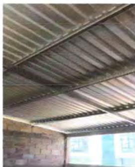
Foto 1: Instalacion de lámina
