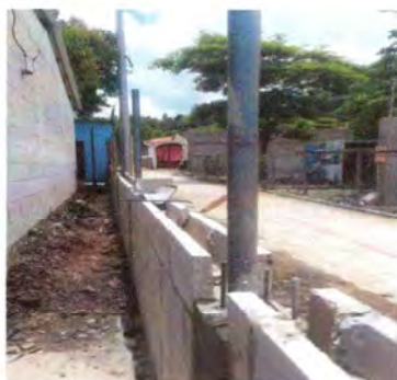
Foto 9: Constucción de muro perimetral
