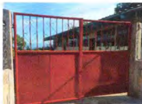
Foto7: Instalación de Portón
