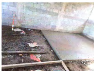
Foto 5: Construcción de concreto liso
