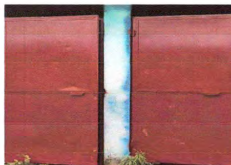
Foto 4: Reparación de puertas
