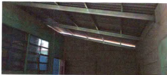
Foto 2: Estructura del techo nueva ya instalada.
