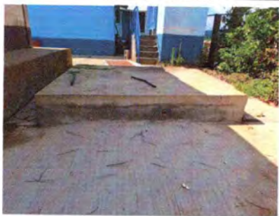
Foto 9: Losa de patio terminada.
