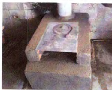
Foto 10: Nueva cocina terminada.
