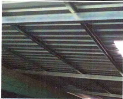
Foto 1: Nueva lámina ya instalada.
