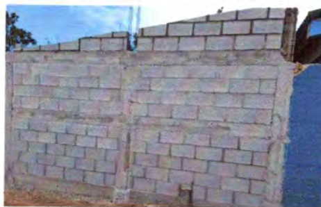
Foto 8 : Nuevo muro perimetral
