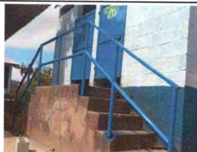
Foto 6: Nueva baranda ya instalada.
