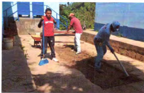
Foto 9: Trabajando en la nueva losa del patio
