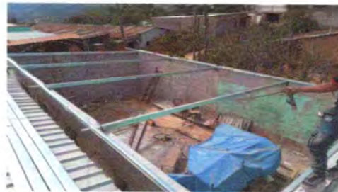
Foto 2: Cambiando la estructura del techo
