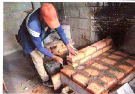
Foto 10: Instalando la nueva cocina.
