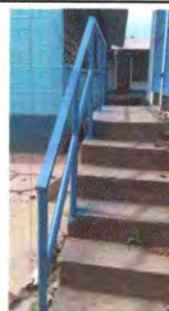
Foto 6: Cambiando la baranda
