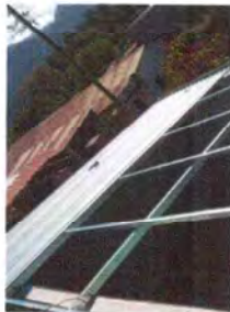
Foto1: Instalación de lámina troquelada.
