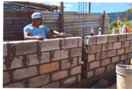
Foto 8: Trabajando en el nuevo muro perimetral
