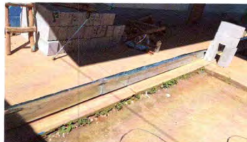
Foto 4: Los canales que se van a instalar
