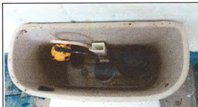
Foto 3: Reparacion de servicios sanitarios
