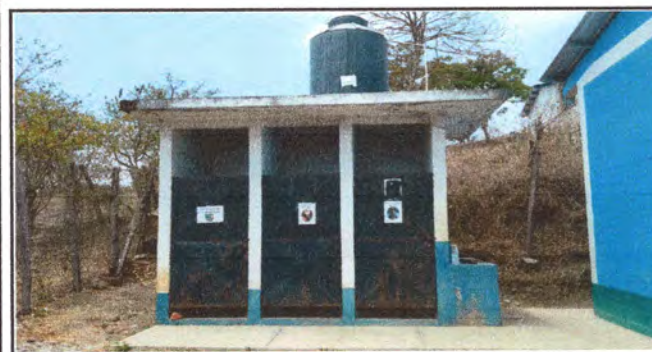
Foto 5: Mantenimiento de tuberias de aguas servidas
