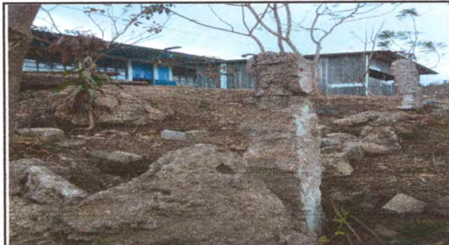
Foto 2: Reparacion de Muro de Contencion
