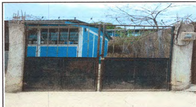
Foto 4: Reparacion de porton de ingreso
