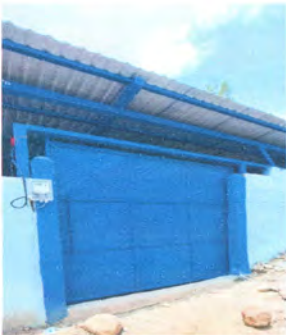
Foto 5: Mantenimineto terminado del porton.
