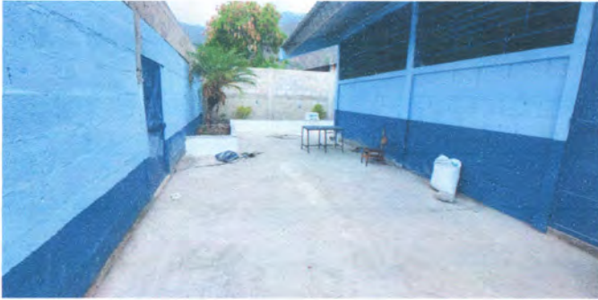
Foto1: Loza de Patio terminada
