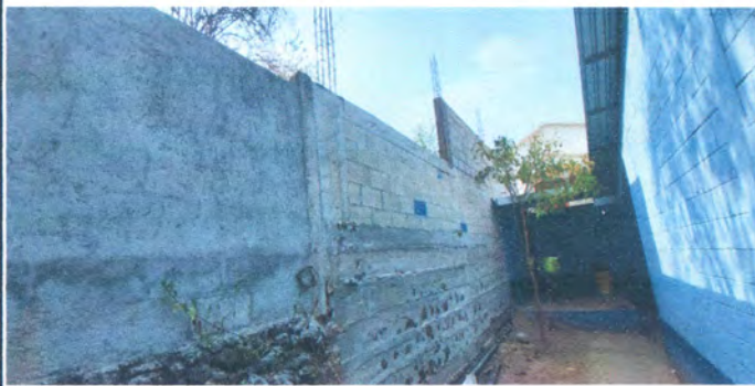
Foto 3: Pared terminada del Muro Perimetral.
