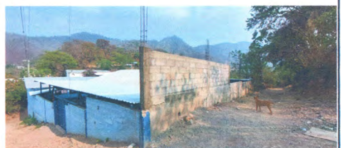
Foto 6: Levantamiento de pared de muro perimetral.
