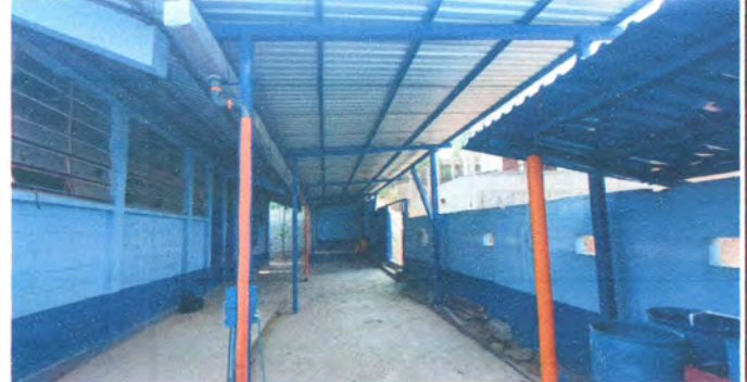
Foto 4: Estructura metalica y lamina troquelada ya instaladas.
