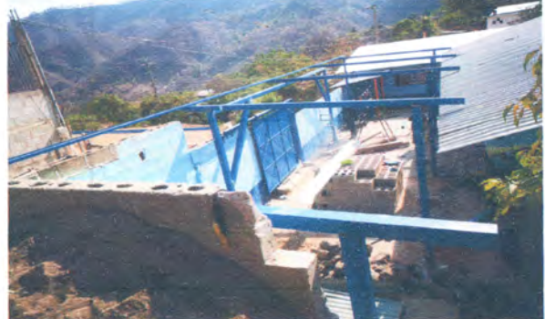
Foto 4: Estructura instalada para colocación de lamina troquelada.
