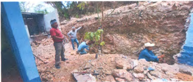
Foto 5: Corte nivelación a plomo de muro de contención previo a su fundición.
