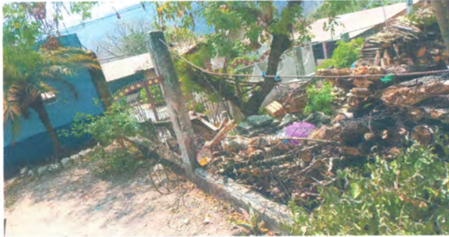
Foto1: Reparación y levantamiento de muro perimetral.
