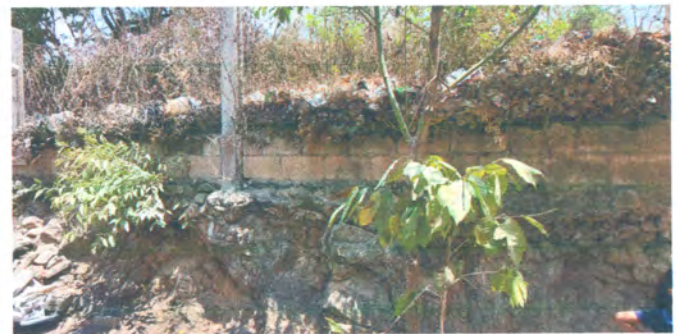
Foto4: Reparación y reforzamiento de muro perimetral.
