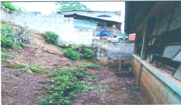
Foto3: Reparación de muro de contención.
