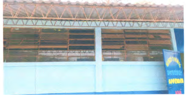
FOTO 2: Mantenimiento y restauración de ventanales.
