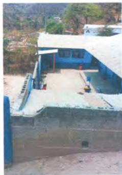
Foto: 5 continuación de suministro e instalación de lamina Troquelada calibre 26.
