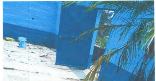
Foto: 6 Reparación de Loza de patio exterior.
