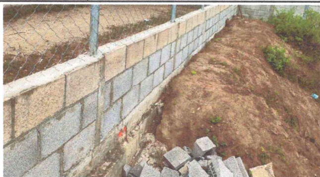
Foto1: Sustitución muro de block pineado
