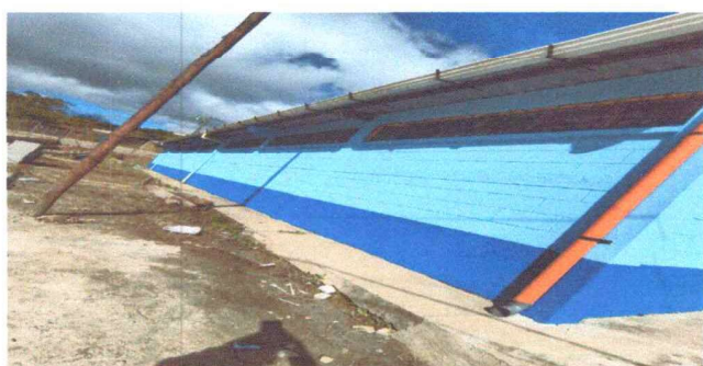
Foto 6: Sustitución de pintura de aceite (Zocalo)
