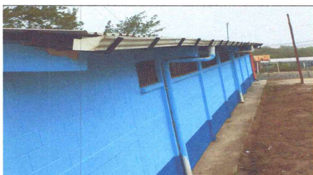
Foto 4: Reparacion y mantenimiento de canales y bajadas 4"
