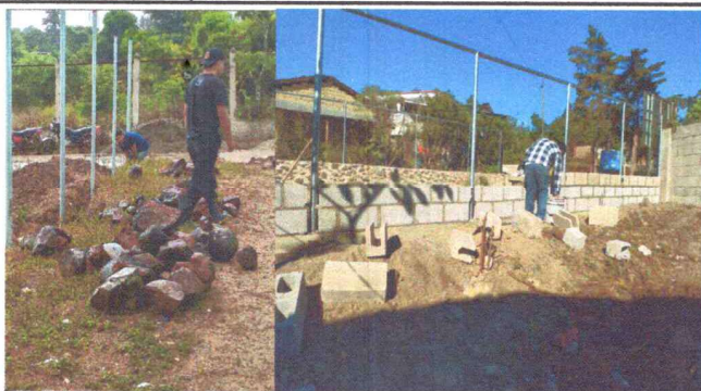
Foto 1: Sustitución muro de block pineado
