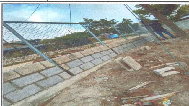
Foto 2: Sustitución de cerco perimetral con block y maya
