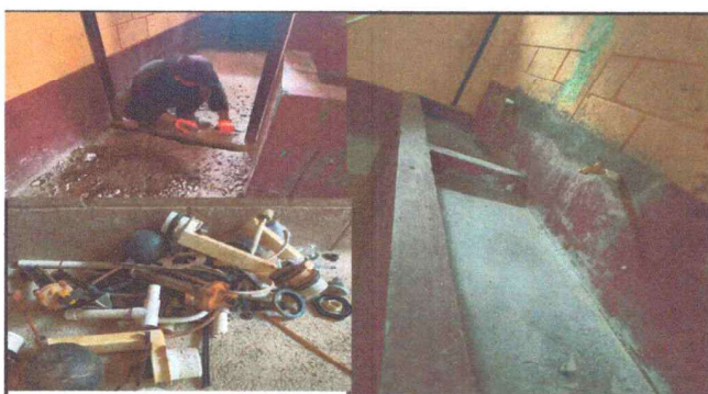
Foto 3: Sustitución de accesorios internos y tapadera
