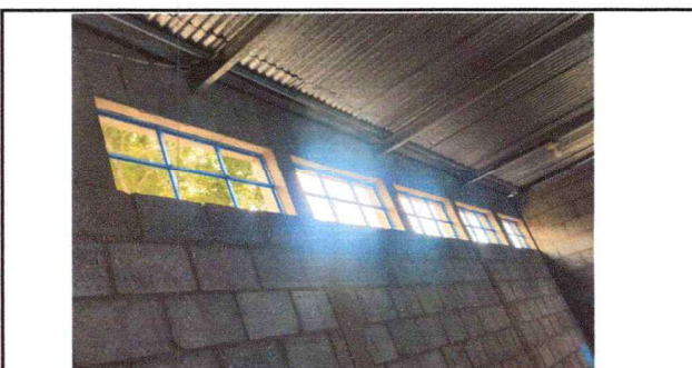
Foto 6: Instalación ventanas con vidrio finalizada
