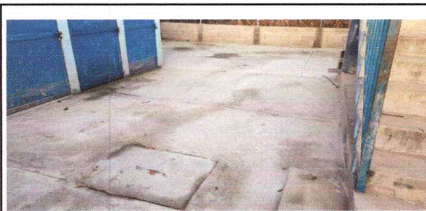
Foto 4: Losa de patio finalizada
