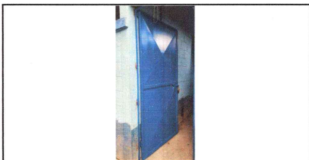
Foto 5: Instalación de puerta de metal finalizada
