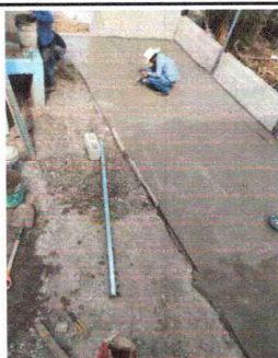
Foto 5: Fundición de losa de patio
