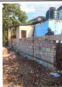
Foto 2: Sustitución muro perimetral
