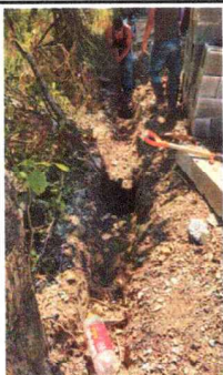
Foto 3: Zanjero para muro de block con malla
