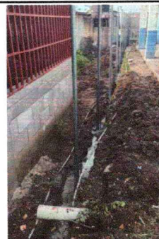
Foto 4: Colocación de postes para muro de block con malla
