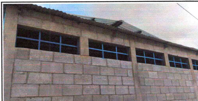
Foto 6: Instalación de ventanales
