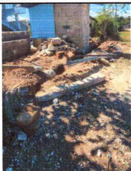
Foto 1: Zanjero para sustitución de muro perimetral
