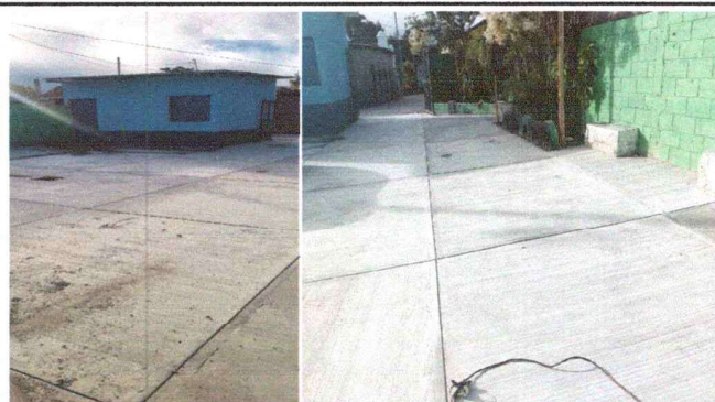
Foto 4: Losa de patio nueva .
