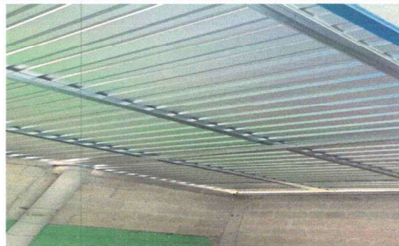
Foto 2: se quito lamina oxidada.
