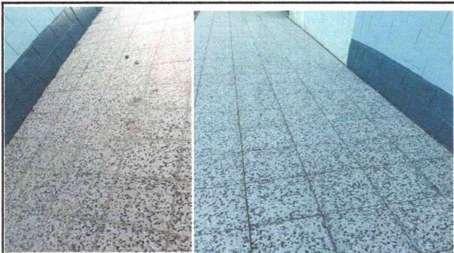
Foto 3: Se observa piso nuevo.
