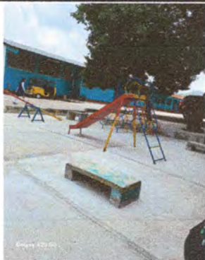
Foto1: LOSA DE PATIO
