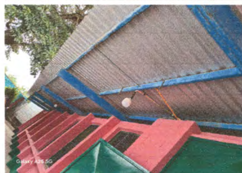
Foto 6: REPARACION DE SISTEMA ELECTRICO
