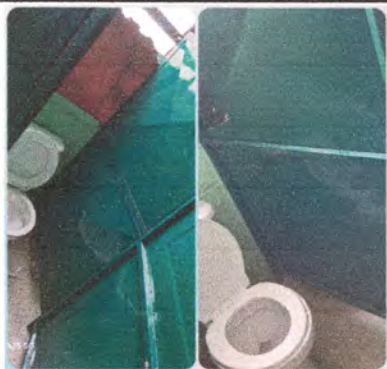
Foto 3: SERVICIOS SANITARIOS Y SUS ACCESORIOS
