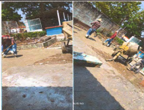
Foto1: LOSA DE PATIO
