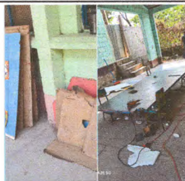
Foto 4: MANTENIMIENTO A PORTONES
