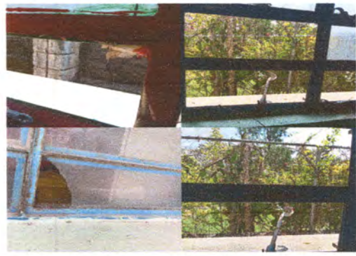
FOTO 2: AREA A TRABAJAR VENTANAL
