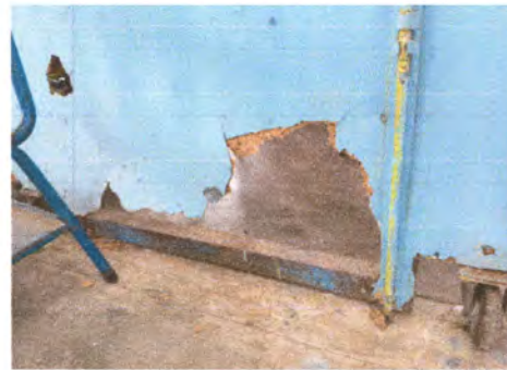
Foto4: AREA A TRABAJAR PORTON DE DIVISION
