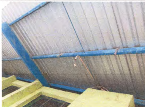
Foto: 5 AREA A TRABAJAR REPARACION SISTEMA ELECTRICO
