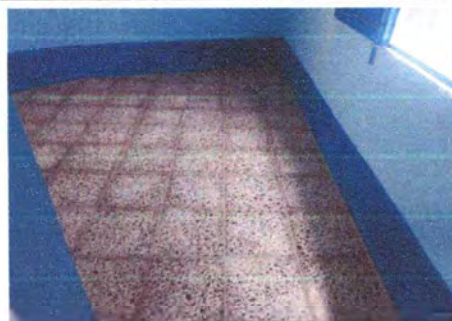
Foto 6: Sustrucción piso de granito en área de cocina.
