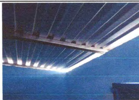
Foto 2: Sustrucción de estructura de techo.
