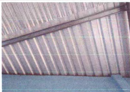
Foto 1: Sustrucción de cubierta de lámina.
