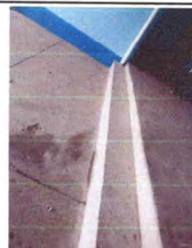
Foto 8: sustrucción cuneta de concreto.
