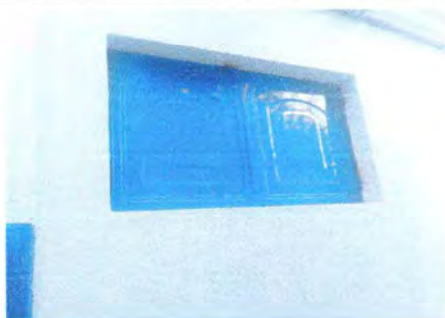
Foto 5: Sustrucción ventana de cocina.
