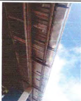
Foto 7: Sustrucción de Canales y bajadas de agua.
