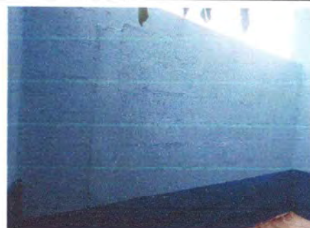
Foto 10: Sustrucción cerco y muro perimetral.
