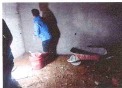
Foto 12: Reparación de repello y cernido de paredes (Sustitución).
