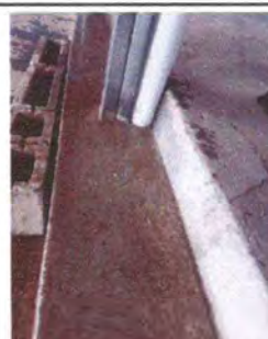
Foto 8: sustitución cuneta de concreto.
