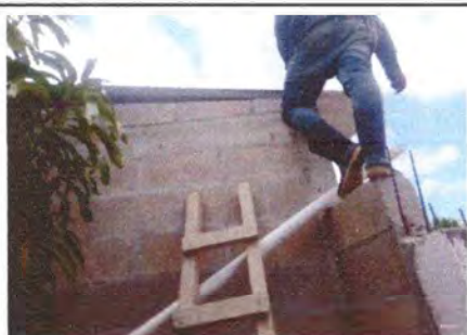
Foto 7: Sustitución de Canales y bajadas de agua.
