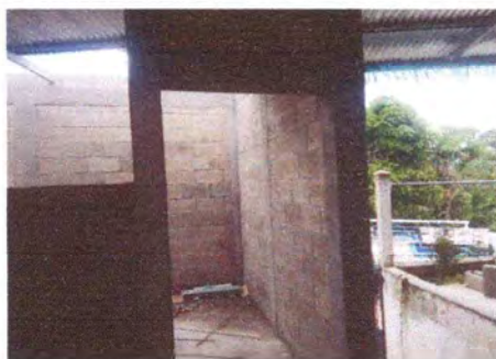
Foto 3: Sustitución de puerta.
