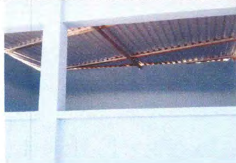
Foto 4: Sustitución de ventana de aula.
