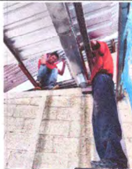
Foto 2: Sustitución de estructura de techo.
