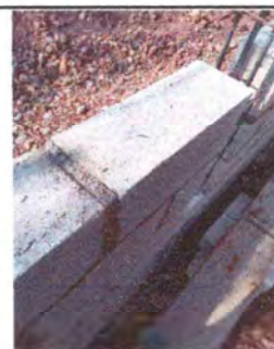
Foto 10: Sustitución cerco y muro perimetral.
