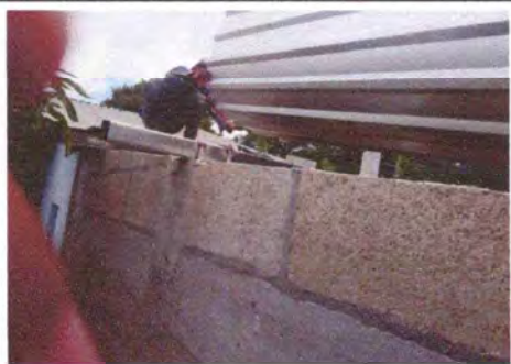
Foto 1: Sustitución de cubierta de lámina.
