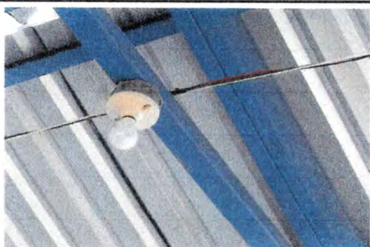
Foto 5: Reparación de sistema eléctrico
