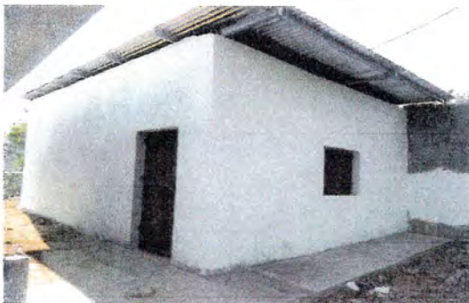
Foto1: Reparación de área de cocina: puerta, ventana, estufas, pilas, chimineas repello estructura, techo
