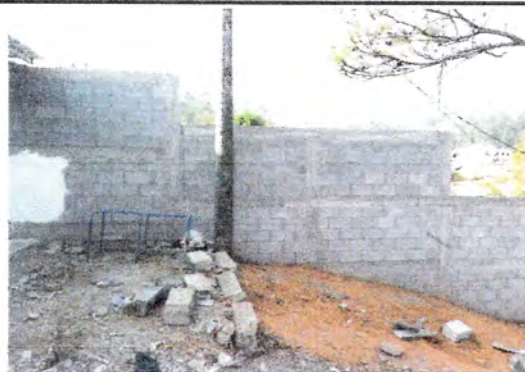
Foto 2: Reparación de muro perimetral
