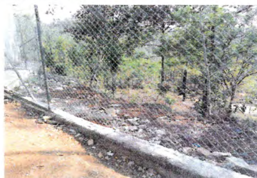
Foto 4: Reparación de cerco perimetral
