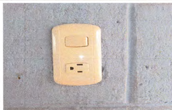
Foto 6: Reparación de sistema eléctrico
