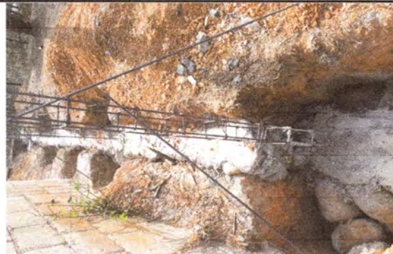
Foto 2: Reparación de muro perimetral
