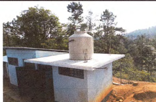
Foto 4: Reparación de sisterna, (depósito de agua)
