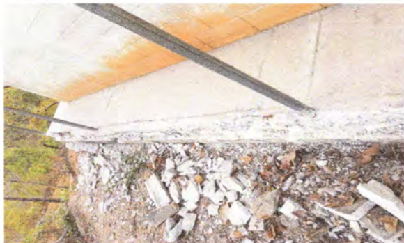
Foto 1: Reparación de cerco perimetral
