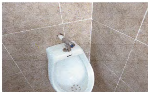
Foto 3: Reparación de baños y sus accesorios
