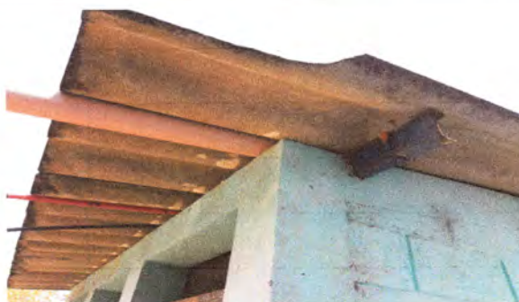
Foto: 6 Reparación de techo (baños)
