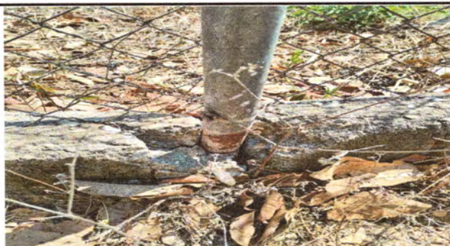
Foto: 5 Reparación de cerco perimetral
