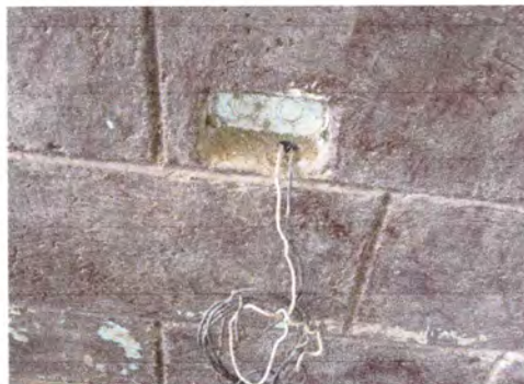
FOTO 2: Reparación de sistema eléctrico
