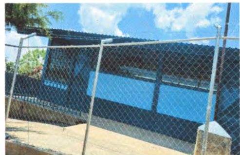
Foto 6: colocación de tuvos galvanizado finalizado
