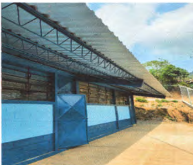
Foto 3: finalización de pintura en exterior y puertas
