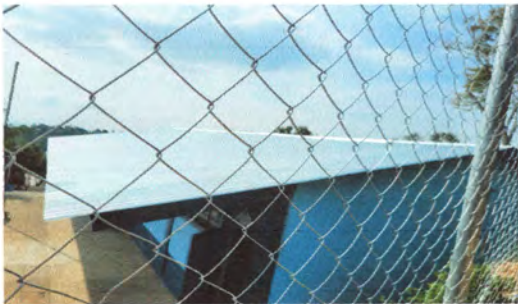
Foto 5: colocacion de maya finalizado
