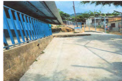
Foto 4: Finalización de plancha de concreto
